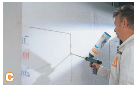
c Открытые щели между плитами нужно заполнить монтажной пеной под давлением
