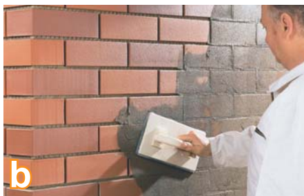
b Заделку швов раствором RSS можно начинать через 7 дней после приклеивания плитки. Раствор для заполнения швов quick-mix RSS с консистенцией шлама нужно наносить диагонально к расположению швов с помощью кельмы с твердым покрытием из резины или резинового скребком. Раствор тщательно вдавливайте в швы между плиткой. Излишки раствора удалите с помощью кельмы с покрытием из резины. После схватывания раствора поверхность плиток несколько раз очистите с помощью влажной губки (quick-mix RSS используйте только для невпитывающей глазурованной плитки с гладкой структурой)
