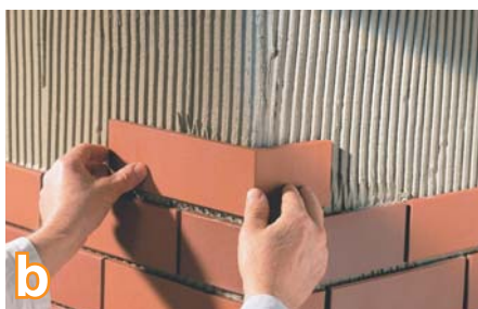
b Приклеивание клинкерной плитки нужно начать с углов здания. Рекомендуется использовать угловые плитки, благодаря этому мы получим эстетичный и долговечный фасад.
