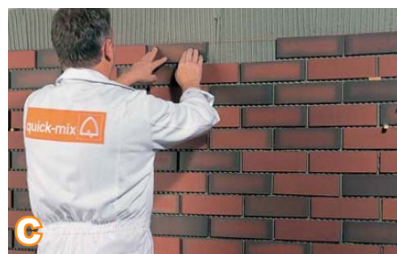
c Затем плитки крепко вдавите в поверхность раствора, не допуская при этом появления пустот и свободного пространства. После облицовки толщина раствора должна составлять не менее 3 мм. После схватывания швы нужно выскести и очистить на соответствующую глубину (не менее чем на толщину облицовочной плитки)
