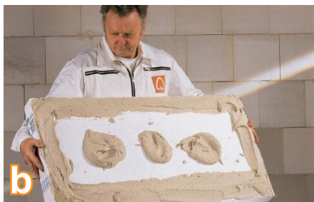
b Приклеивание изоляционных плит раствором quick-mix RKS точечным бортовым методом
