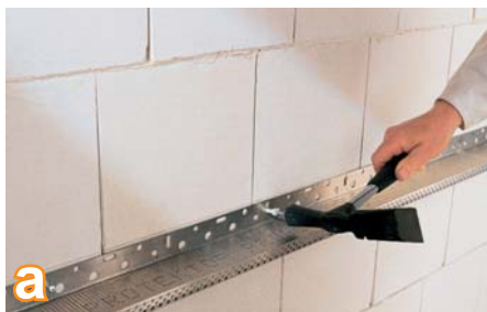
a Перед приклеиванием изоляционных плит необходимо установить цокольные профили
