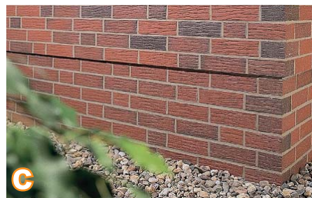
c Система LOBATHERM P с клинкерной плиткой в качестве прочной, экономичной и эстетичной альтернативы лицевому клинкерному кирпичу.
