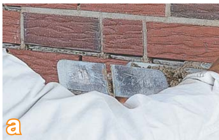
a Заделку швов можно начинать минимум через 14 дней после приклеивания плиток. Раствор для заполнения швов quick-mix RFS с консистенцией «мокрой земли» нужно тщательно вдавливать в швы с помощью кельмы для швов. Герметично заделывайте швы в два рабочих цикла по методу «свежее на свежее»
