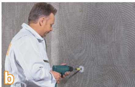
b Установка механических дюбелей с металлическим сердечником производится непосредственно после нанесения первого слоя раствора RAS. Дюбелирование производится в свежий раствор
