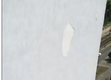
**Недостатня технологічна перерва між влаштуванням гідрозахисного та декоративного шару.** Технологічна перерва між свіжовлаштованим гідрозахисним та влаштуванням декоративного шару повинна бути не менше 3 діб. Недотримання технологічної перерви може спричинити відшарування декоративного шару та сприяти появі висолів.
