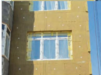
**Заповнення швів між плитами утеплювача.** Ширина швів між плитами утеплювача повинна складати не більше 2 мм. У разі виникнення швів, ширини яких понад 2 мм, їх необхідно розширити та заповнити смугами з того самого матеріалу, що і плити утеплювача. Заповнення швів клейовою або армувальною розчиновою сумішшю приведе до утворення містків холоду, що в свою чергу знизить ефективність теплоізоляційного шару.
