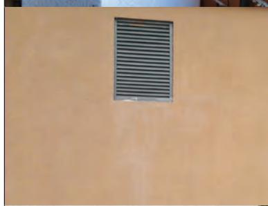
**Відсутність герметизації місць примикання утеплювача до віконних, дверних та воротніх блоків** приводить до зволоження теплоізоляційного шару, що в свою чергу приводить до утворення плямистостей та пліснів на поверхні фасаду і як правило руйнування системи.
