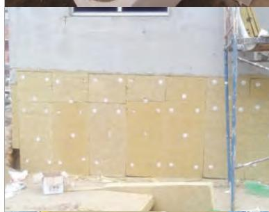
**Монтаж плит утеплювача зі збігом вертикальних швів.** Неправильна перев'язка плит утеплювача знижує міцність системи в цілому. Приkleювання плит зі зміщенням вертикальних швів дає змогу підвищити монолітність конструкції та зробити поверхню фасаду достатньо рівною.
