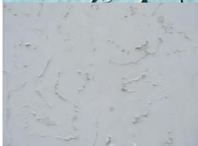
**Відлущування фарби.** Відлущування — це втрата зчеплення фарбувального покриття з поверхнею. Відлущування фарби може спричинити неякісна підготовка поверхні.
