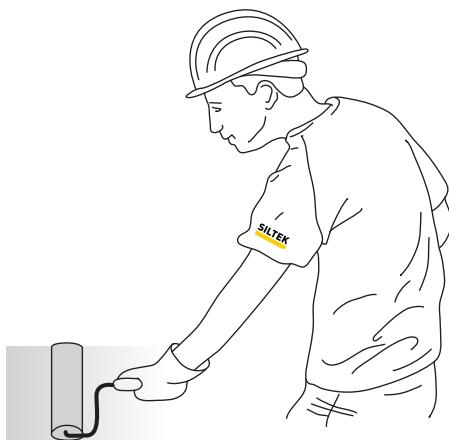
• фарбу перед використанням слід ретельно перемішати. Наносити на сухі (вологості до 4%) погрунтовані поверхні щіткою, валиком або фарборозпилювачем рівномірно, без пропусків, в два шари. При нанесенні першого шару (ґрунтувального) в фарбу необхідно додати до 10% води від її об'єму та ретельно перемішати. Другий шар наноситься після висихання першого. При нанесенні другого шару у жарких та сухих умовах (до +30 °C) можливе додавання до 5% води від об'єму фарби;
