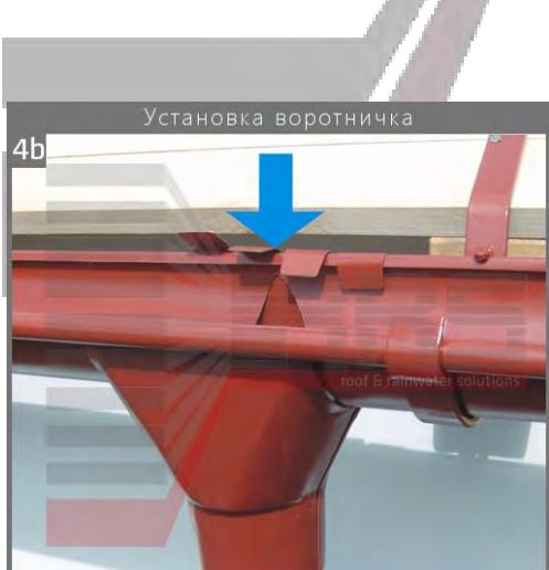
Далее прижмите воронку к желобу и зафиксируйте ее, загнув резной фланец воронки на внутреннюю кромку желоба [4b].
