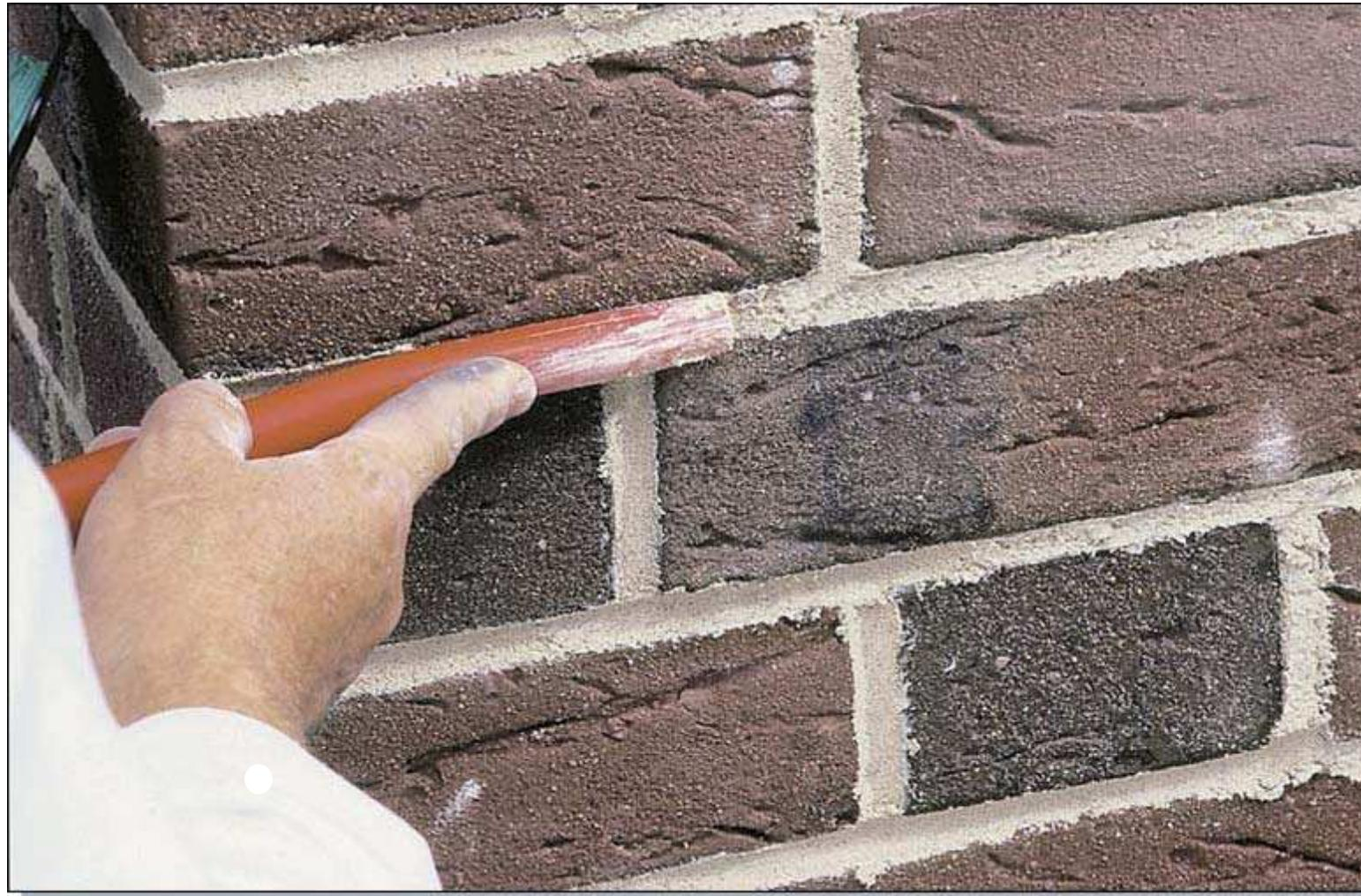
На углах швы нужно проходить так, чтобы вдавить раствор в шов, в направлении от угла к кладке.
