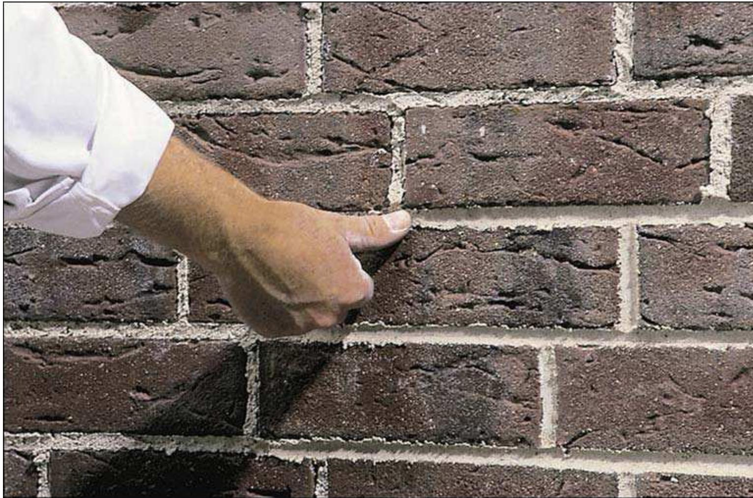
Необходимо провести „тест большого пальца“, чтобы понять, можно ли уже обрабатывать швы кладки. Расшивка швов кладки должна происходить в момент, когда раствор достиг определенной степени равномерного затвердевания.
