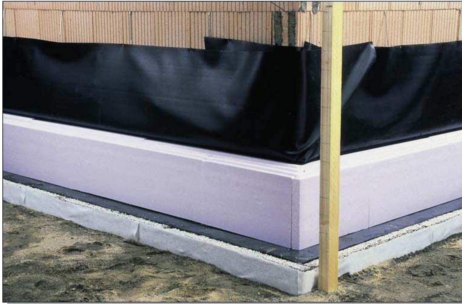
Теплоизоляция под Z-образную изоляцию полностью уложена.
