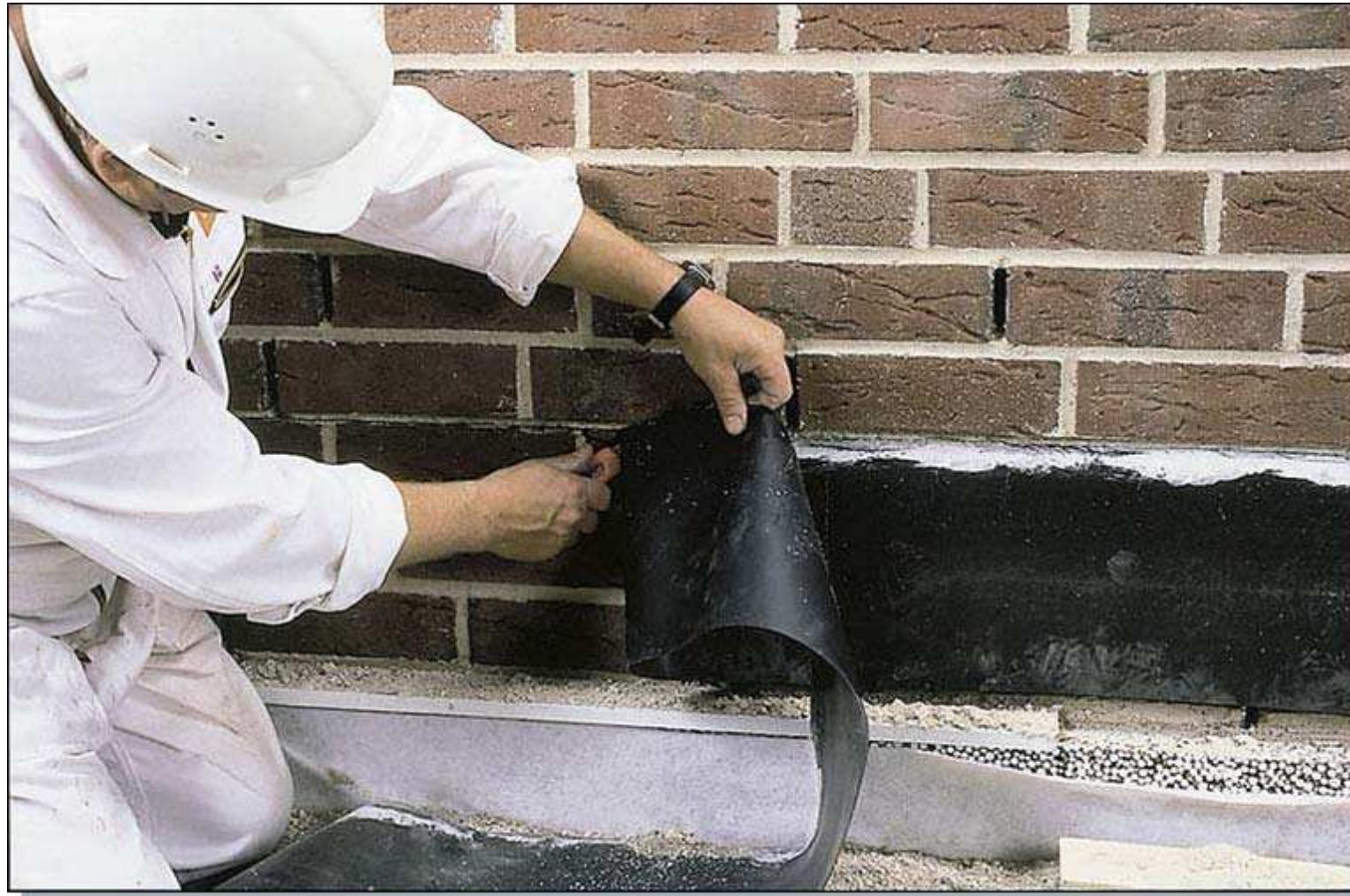
Только когда кладочные работы завершены, мы обрезаем излишки Z-изоляции.
