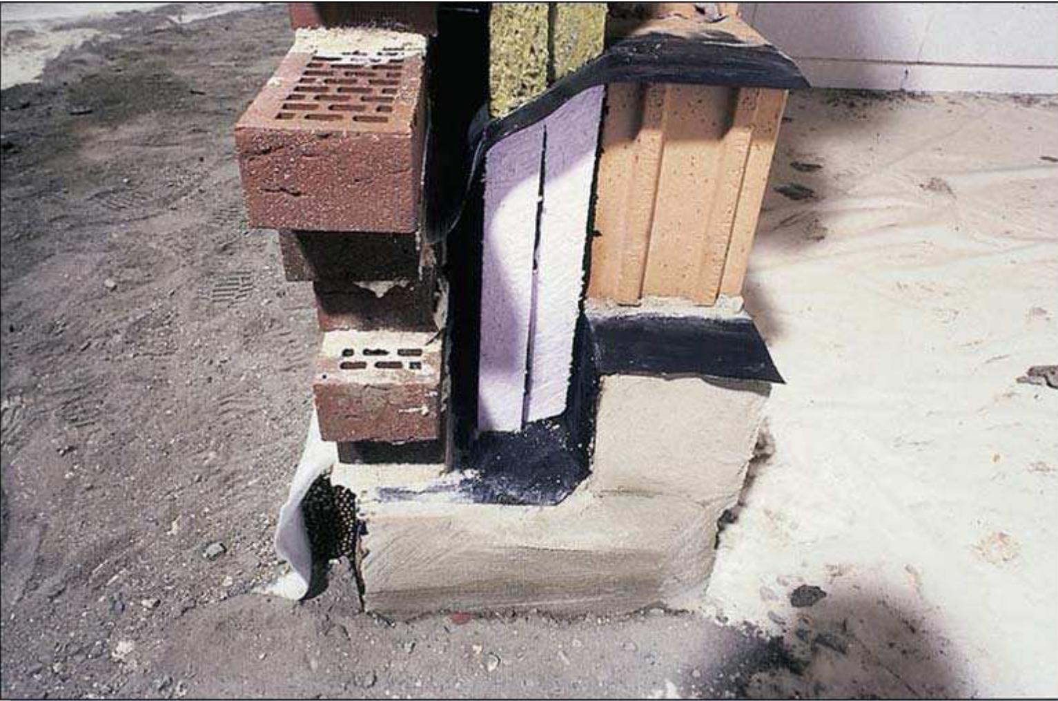
Поперечный разрез стены с изоляцией и вентиляционной щелью.
