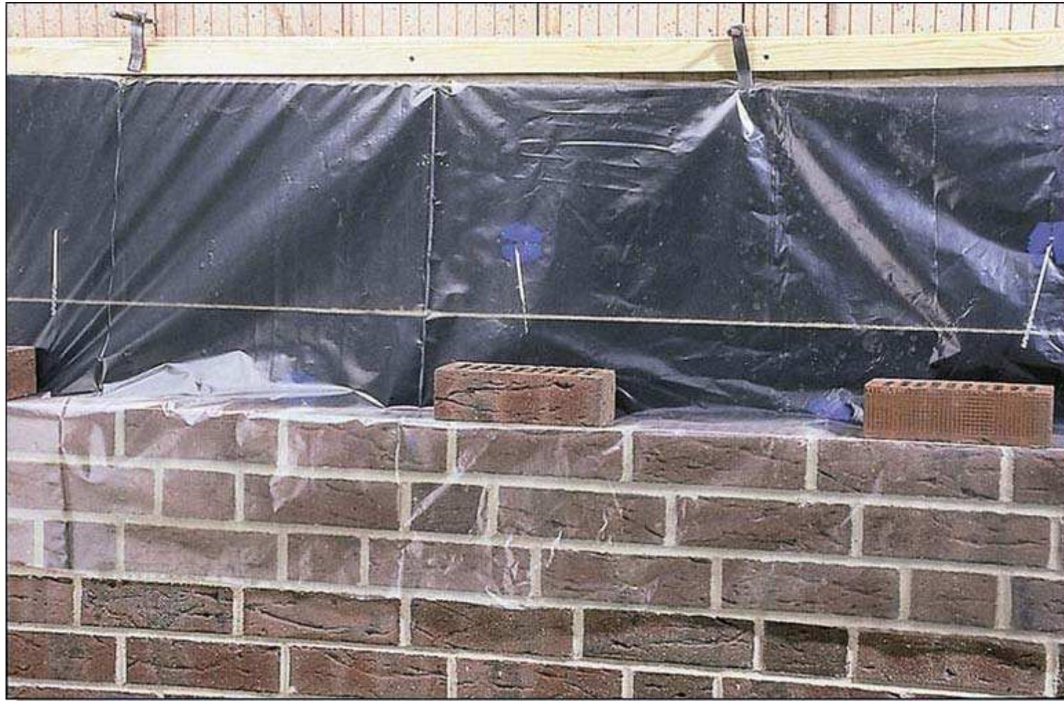
Очень важно накрывать облицовочную кладку для защиты от осадков во время перерыва в работах.
