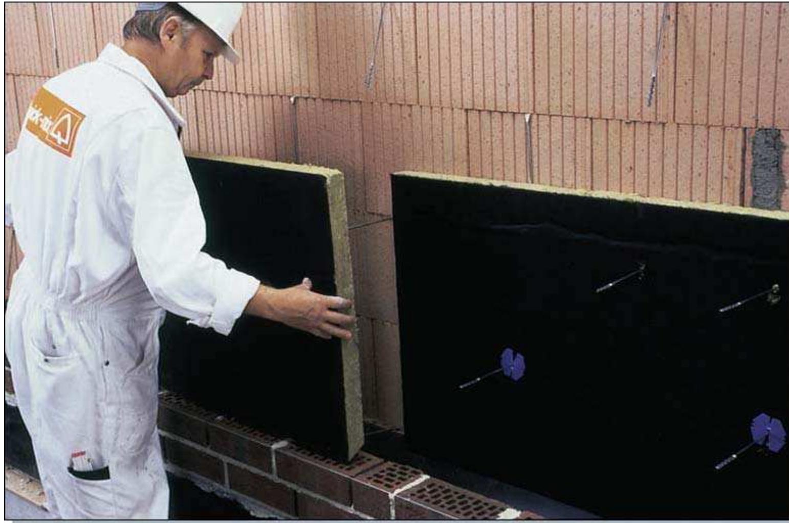
Плиты закрепляются при помощи специальных анкеров.
