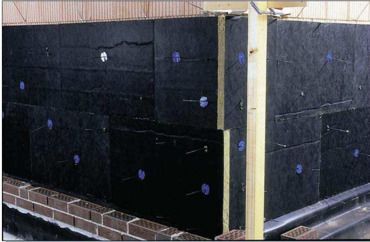
Достаточно сначала закрепить плиты до той высоты, до которой кладка будет поднята в тот же день, так как кладка защищает изоляцию от сырости и механических повреждений.
