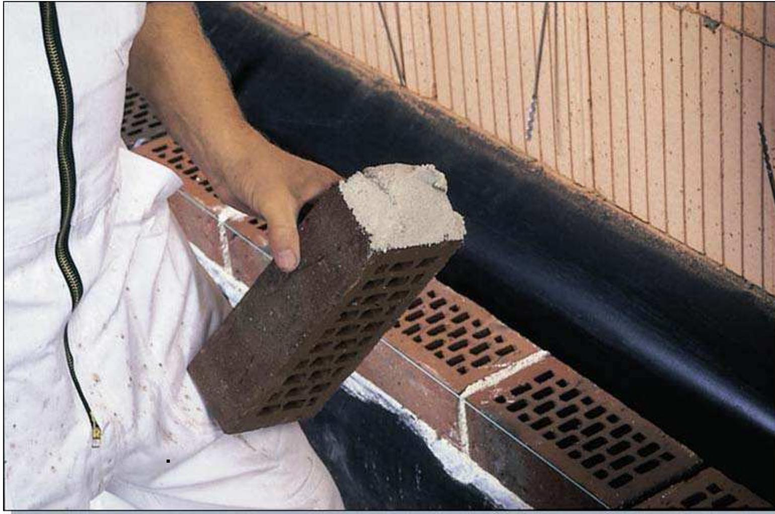
Ряд поверх Z-образной изоляции примерно на 1 см выступает вперед (цоколь). Z-образная изоляция при начале кладки не обрезается. Это необходимо, чтобы сразу было видно, что Z-образная изоляция проложена по всему периметру кладки. Чтобы хорошо заполнить вертикальные швы, кладем достаточно раствора на торцевую поверхность кирпича
