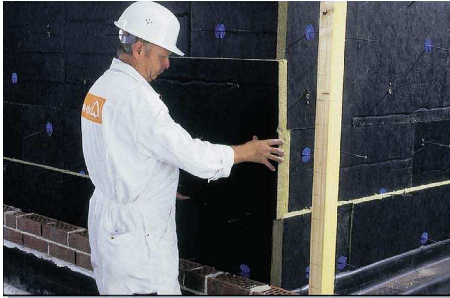
Изоляция выполняется из двух слоёв плит, которые укладываются в разбег, так чтобы стыки перекрывались.
