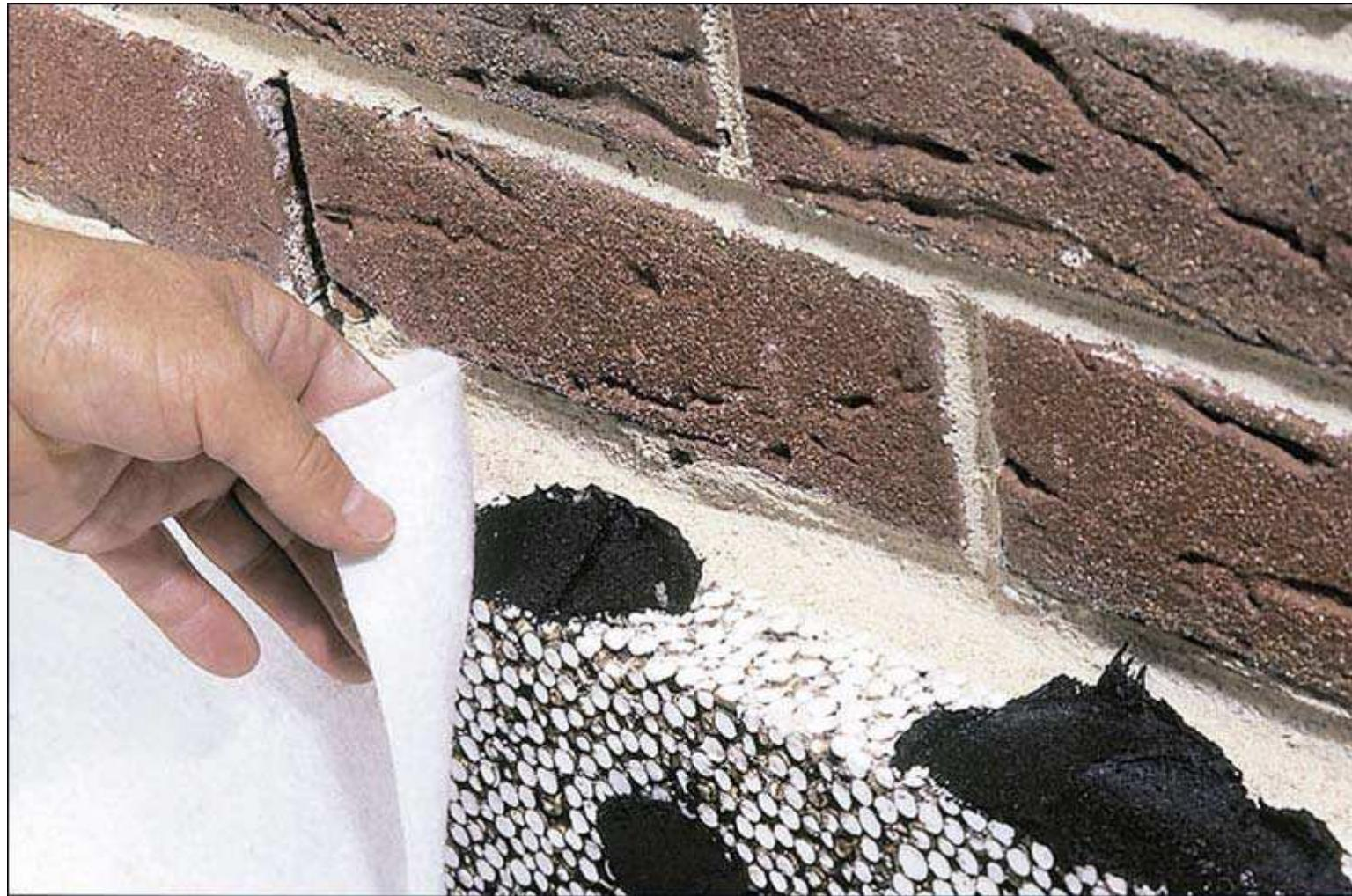
Флис, которым накрывается для защиты от забивания мелкими частицами дренажная плита, должен покрывать и верхнюю её кромку и kleиться битумным kleем без растворителей (клей наносится точечно, а не слоем, чтобы не забить поры)
