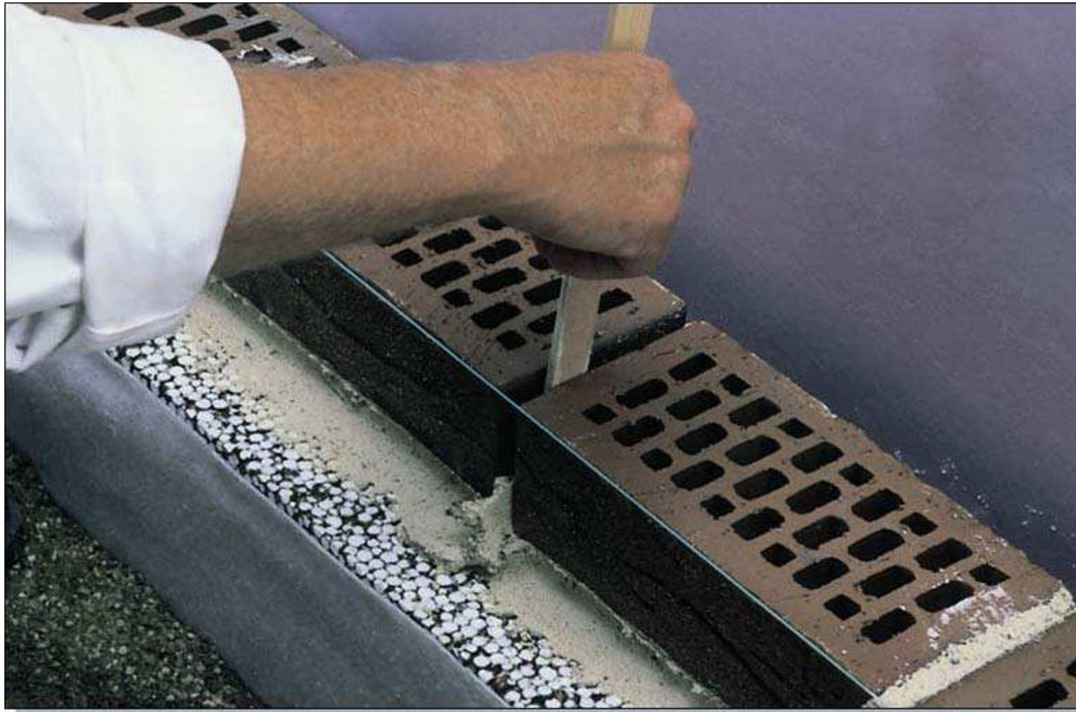
Ширина шва проверяется при помощи деревянной чурки, ширина которой соответствует необходимой ширине шва.
