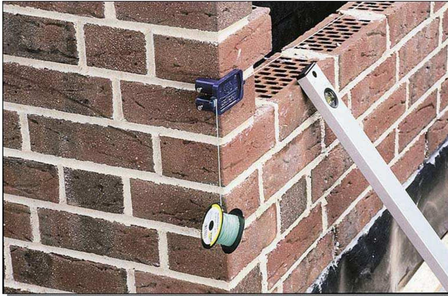
А теперь приступим к облицовке второй стены. Рейку мы убрали и закрепляем шнур прямо по углу кладки.
