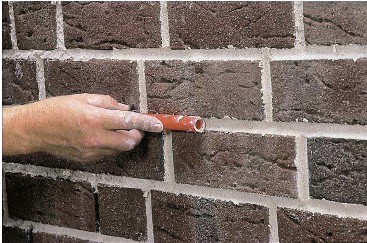
Дополнительное уплотнение раствора нажатием шланга улучшает склеивание раствора и кирпича.
